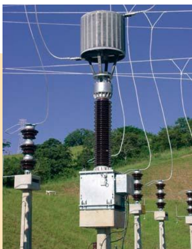
Линейный заградитель на вертикальной опоре А, смонтированный на емкостном трансформаторе напряжения
