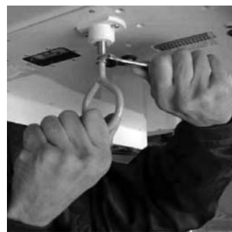
Рис. 4.1. Установка кольца ручного отключения
