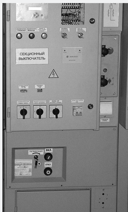
Рис.2 Применение SM/TEL в ячейке КСО
