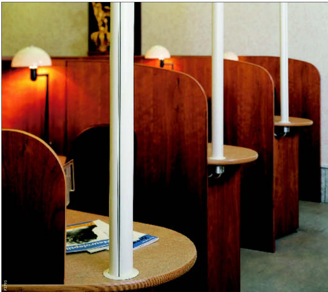
Подводящий профиль, тип FCD-NP, это тонкий трубчатый профиль, обеспечивающий привлекательный и удобный способ подводки кабеля из под потолка к индивидуальному рабочему месту вне зависимости от того, где оно расположено в офисе.
